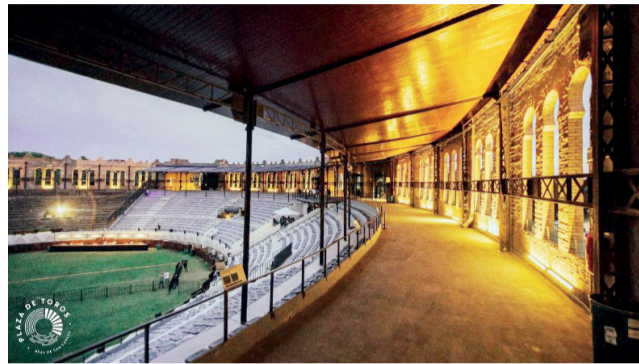
Vista interna de la Plaza de Toros - Colonia Foto: Comunicación Plaza de Toros
