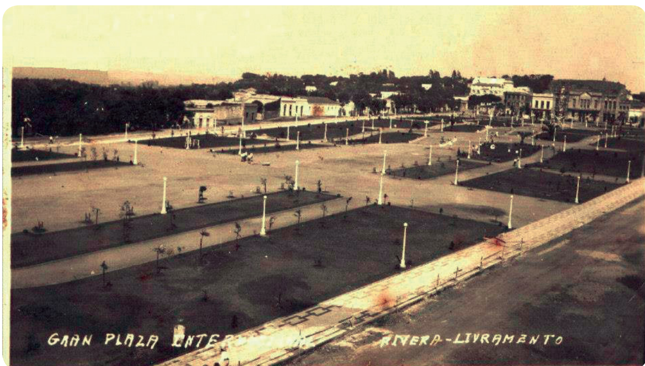
Parque Internacional durante sua construção, na imagem nota-se que ainda não havia a fonte nem o monumento às mães.
